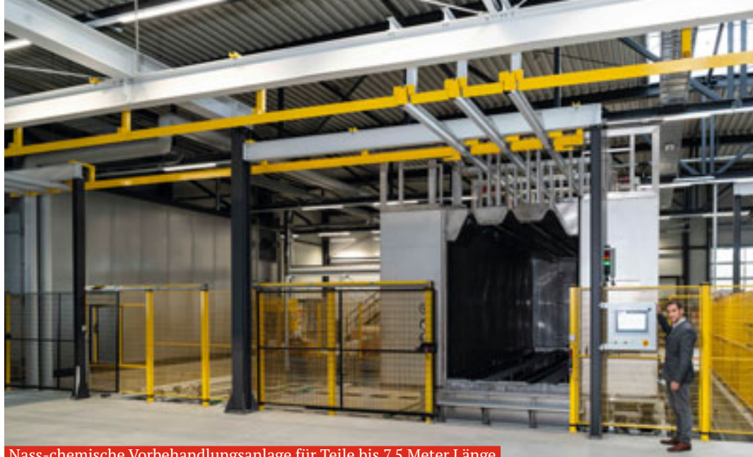
Nass-chemische Vorbehandlungsanlage für Teile bis 7,5 Meter Länge
